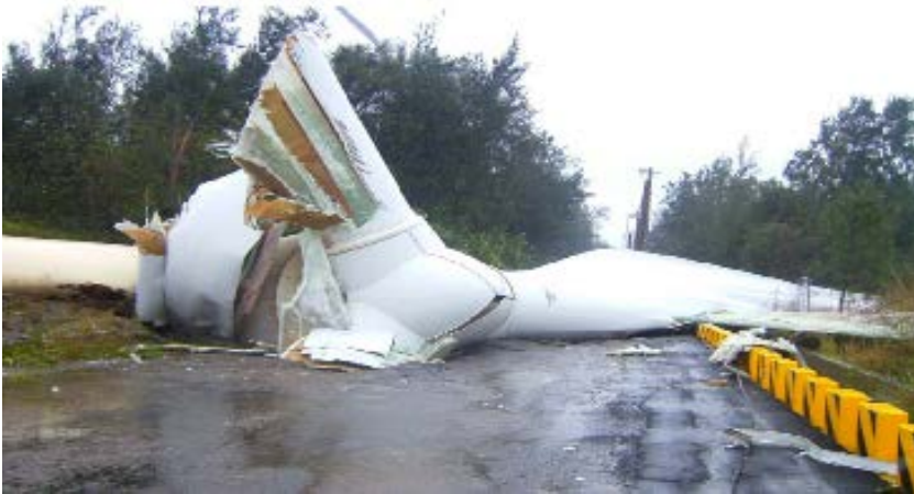
2008年 薔密颱風 台中港區風機倒塌
