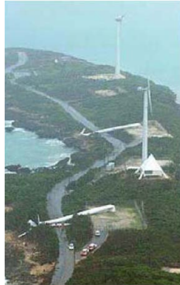
2003年梅米颱風 日本沖繩地區風機倒塌
