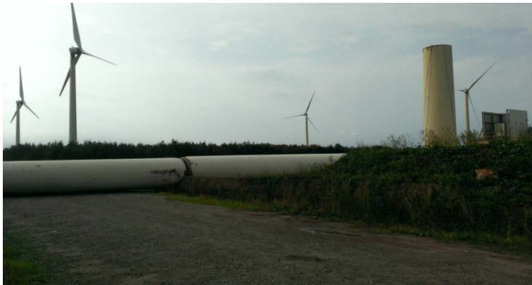
2015年 蘇迪勒颱風 台中港區風機倒塌
