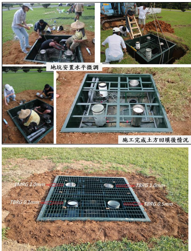
圖6 雨量計地坑施工及完成照
